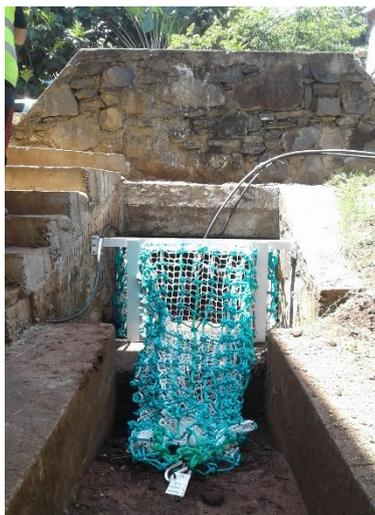
Fixation d'un filet antidéchets en sortie de caniveau à Bouyouni
