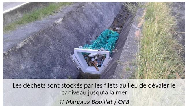
Aucun des douze filets n'est semblable aux autres car chacun est adapté à la dimension de l'ouvrage auquel il est fixé. De même, ils sont posés de manière à ne pas augmenter le risque d'embâcle lors des fortes pluies. Suite aux retours de riverains lors de la phase-test, les agents du Parc et les ingénieurs de Pollustock ont revu les dispositifs pour éviter toute obstruction des cours d'eau.
