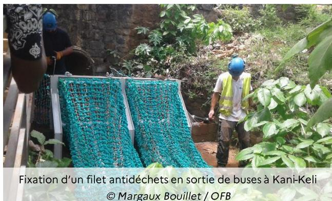
Fixation d'un filet antidéchets en sortie de buses à Kani-Keli
